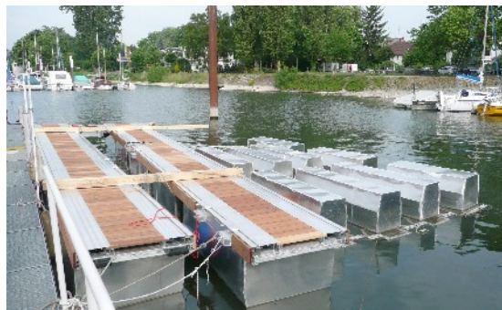
Die Stege liegen für die Endmontage bereit.
