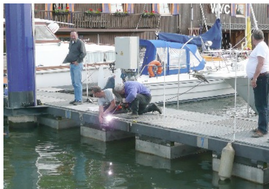
Anschweissen des Aufnahme­flansches
